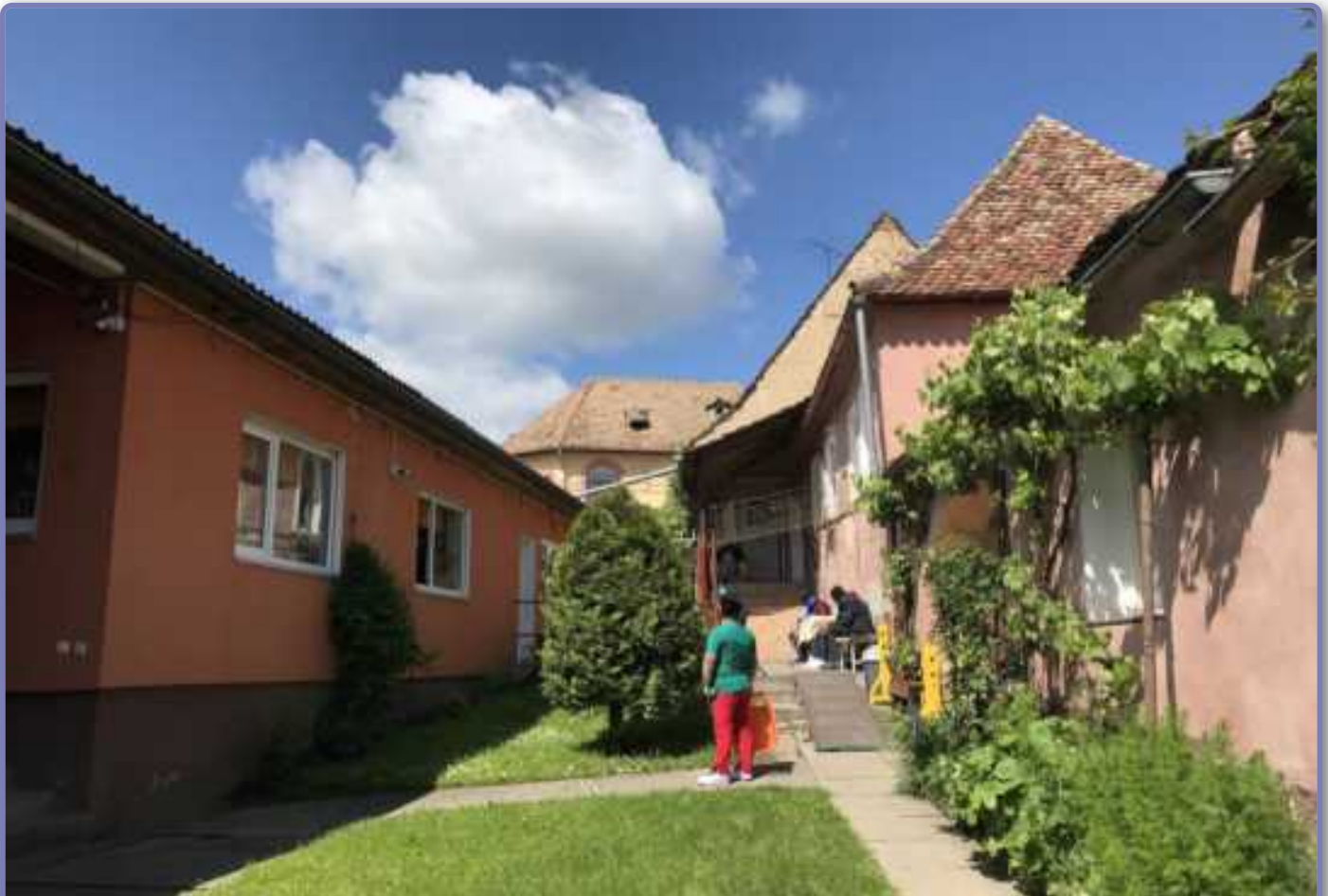
Hetzeldorf 2025 – die zahlreichen Treppen stellen für die Heimbewohner ein zunehmendes Hindernis dar. Die selbstgebauten Rollstuhlrampen sind ein Kompromiss.
