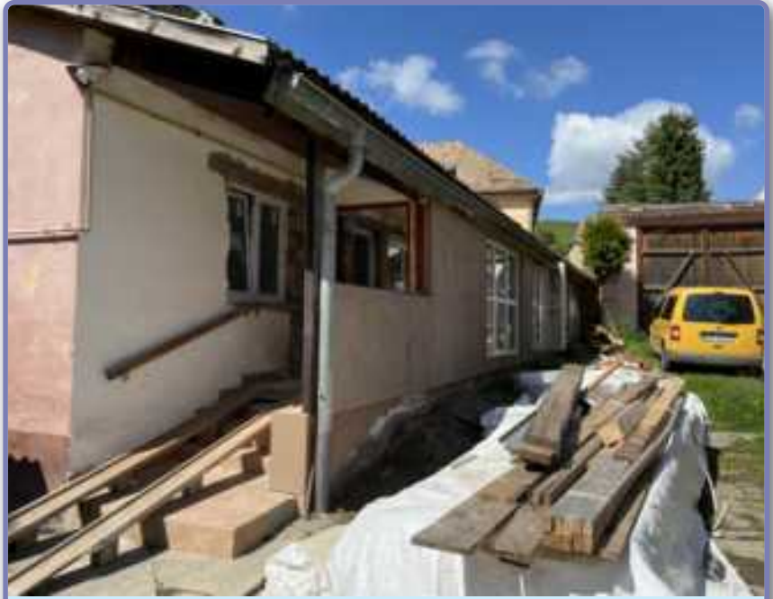
Bauarbeiten in Eigenleistung: Einbau einer Rollstuhlrampe, Austausch von Fenstern.
