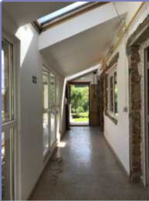
Bauarbeiten in Eigenleistung: Austausch von Fenstern und Türen.
